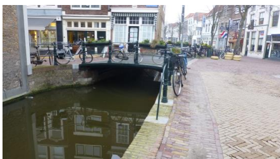
2014 Restauratie Bostelbrug en 2017 Collatiebrug
